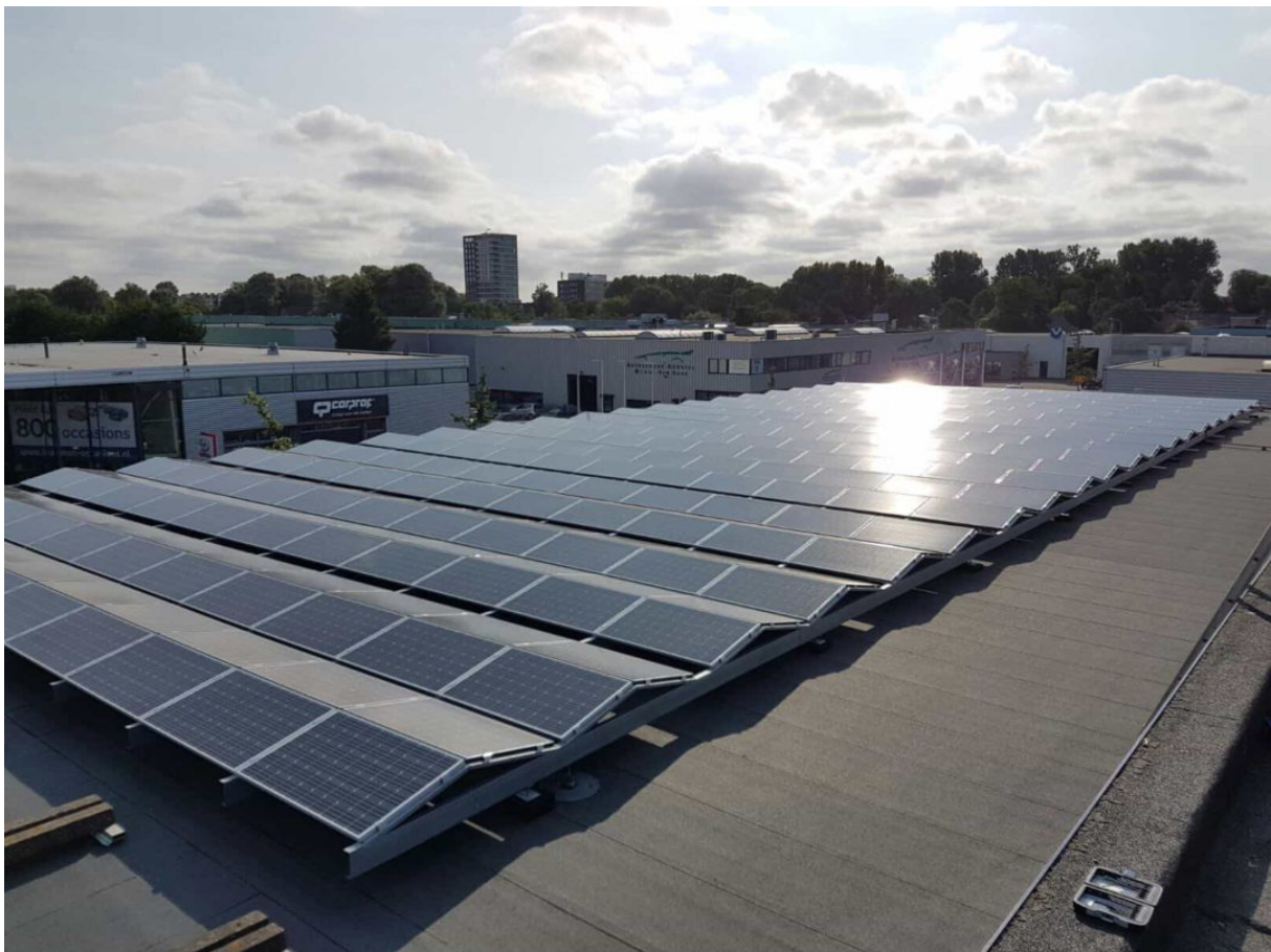
Figuur 17 - Zonnepanelen op bedrijfspand
